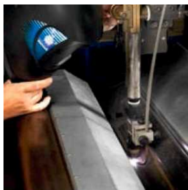
Автоматическая сварка протяженных швов по нержавеющей стали
